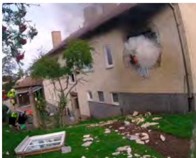
Det blev stora materiella skador i lägenheten efter explosionen och branden.
